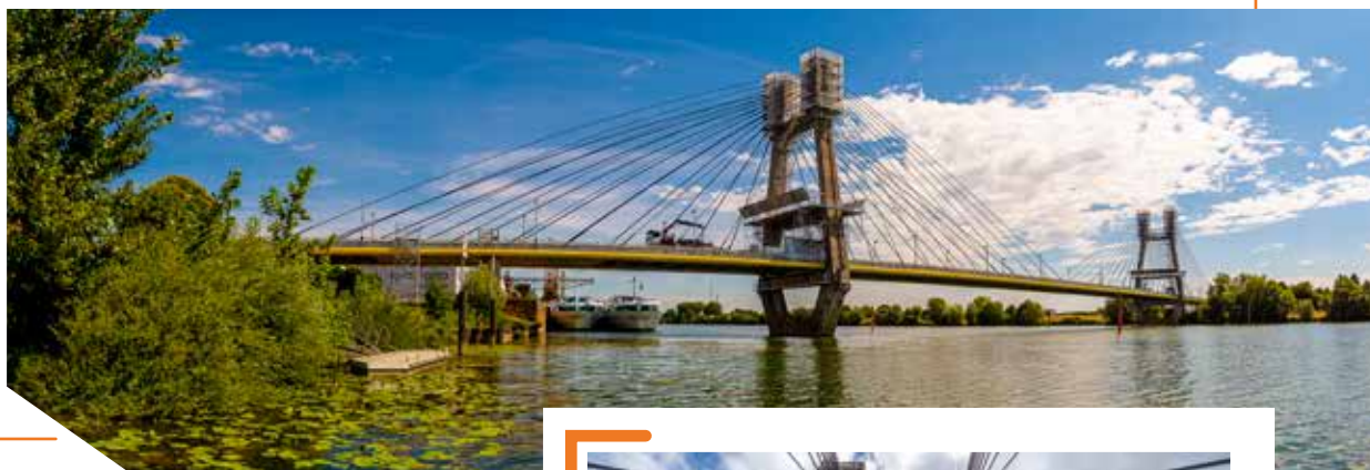
DÉBUT DES TRAVAUX DU PONT DE BOURGOGNE (avril)
