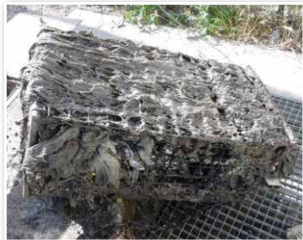
— Accumulation indésirable de lingettes sur une grille —
