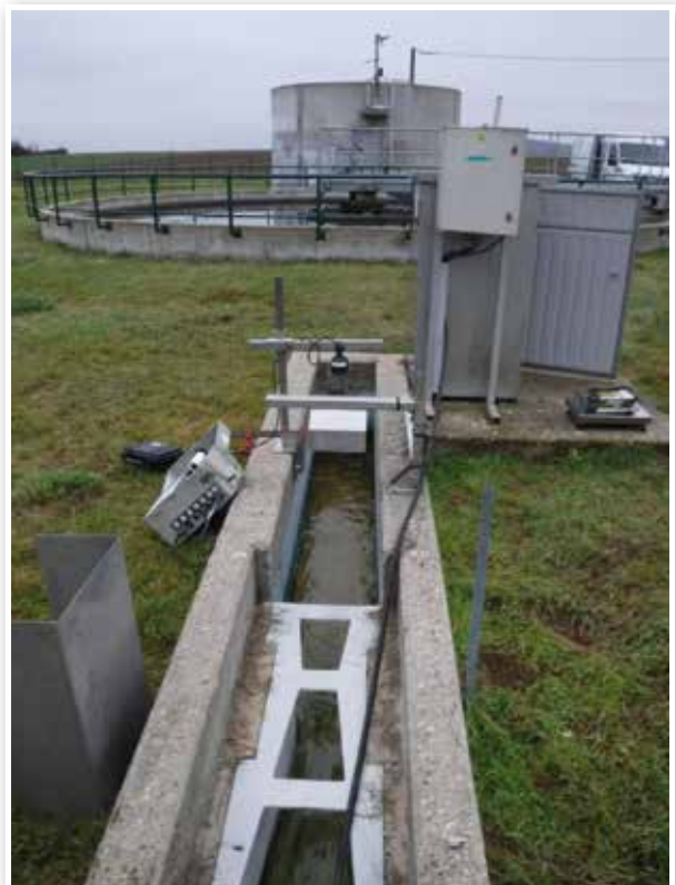
↑ Canaux de mesure de débits en sortie de station d'épuration ↓
