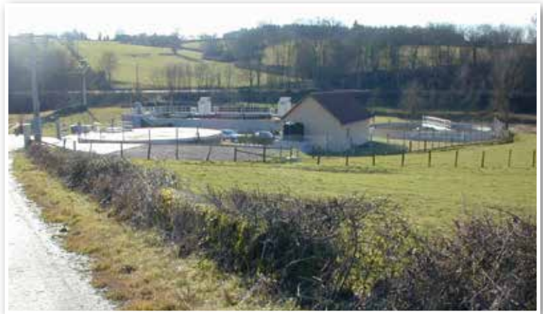
Stations d'épuration de type boues activées
