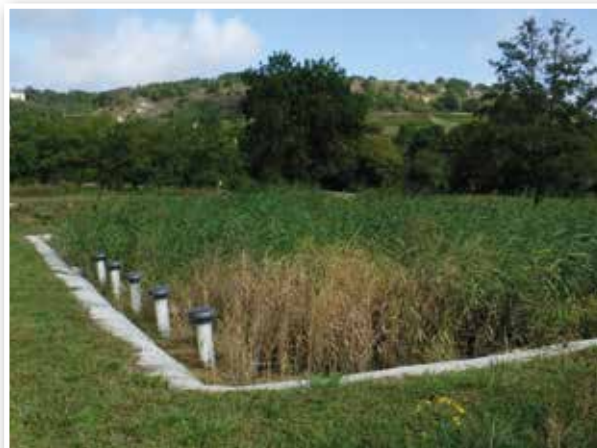
Étages de filtres plantés de roseaux
