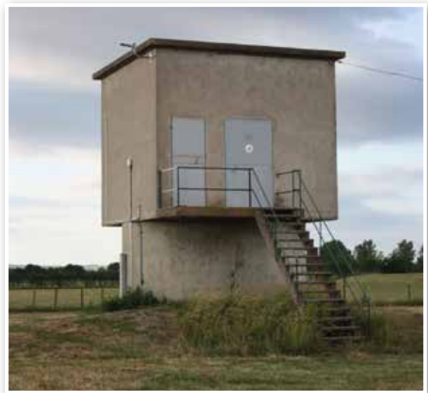
— Puits de captage en nappe alluviale —
