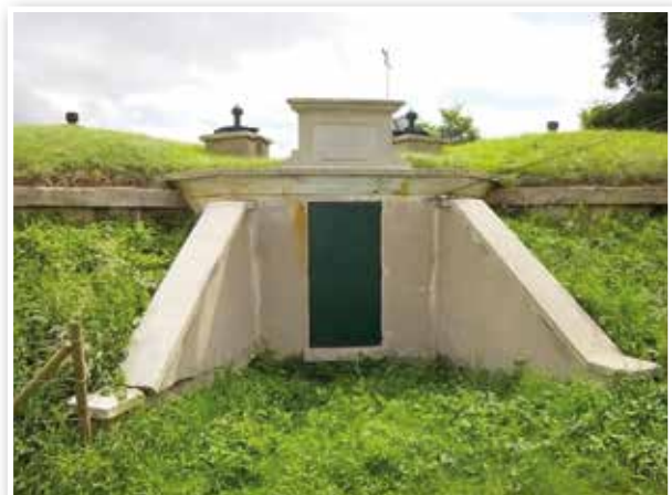
Entrée d'un réservoir semi-enterré
