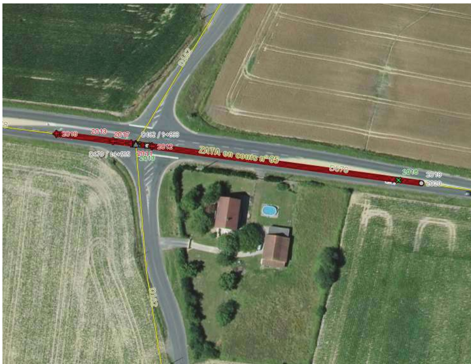
D678 – Lessard en Bresse - Carrefour PR 14+588 - zone d'accumulation d'accident par refus de priorité
