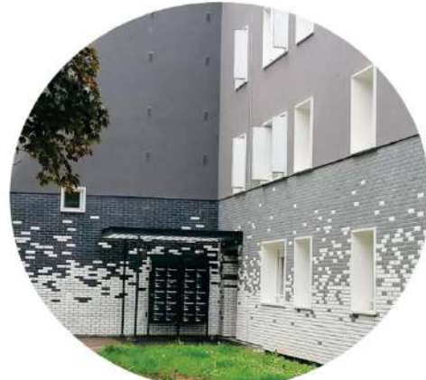
32/ 34/ 36 /38 avenue de la Marne à Sens
