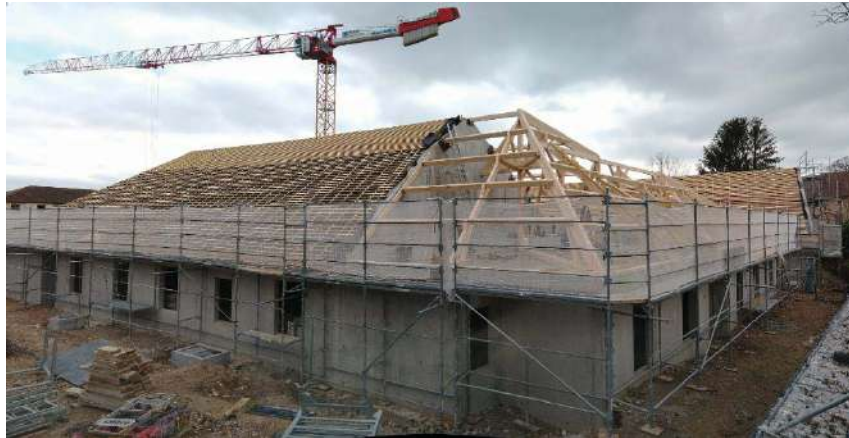
Vue du chantier le 7 janvier 2021
